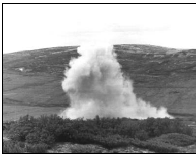
Проходка канав взрывом «на выброс». Лето 1975 г.
