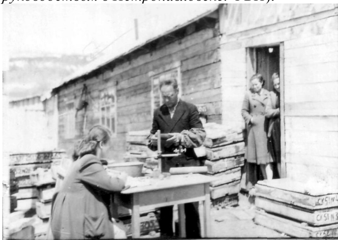
Послойное описание керна под бинокулярной лупой у геологического отдела в п. Богачевка
