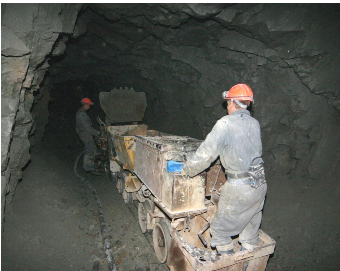
Погрузка породы в подземной горной выработке
