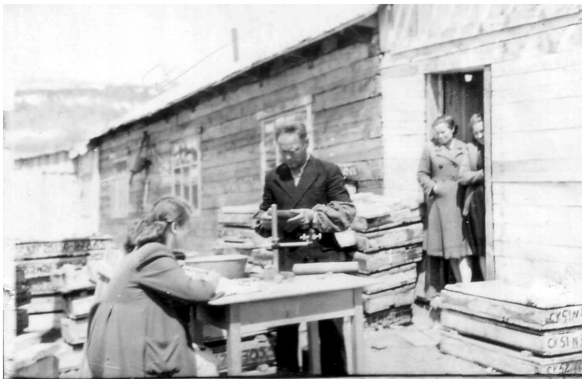
Послойное описание керна под бинокулярной лупой у геологического отдела в п. Богачевка Фото из отчета Л.П. Грязнова, инв. № 143
