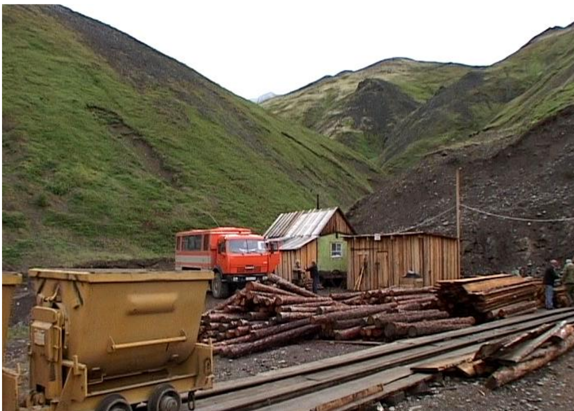
Подготовка к восстановлению подземных горных выработок
