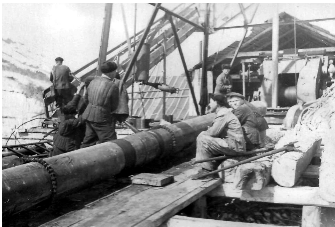
Соединение труб 18" для направления на роторной скважине № Р-3 Фото из отчета Л.П. Грязнова, инв. № 143
