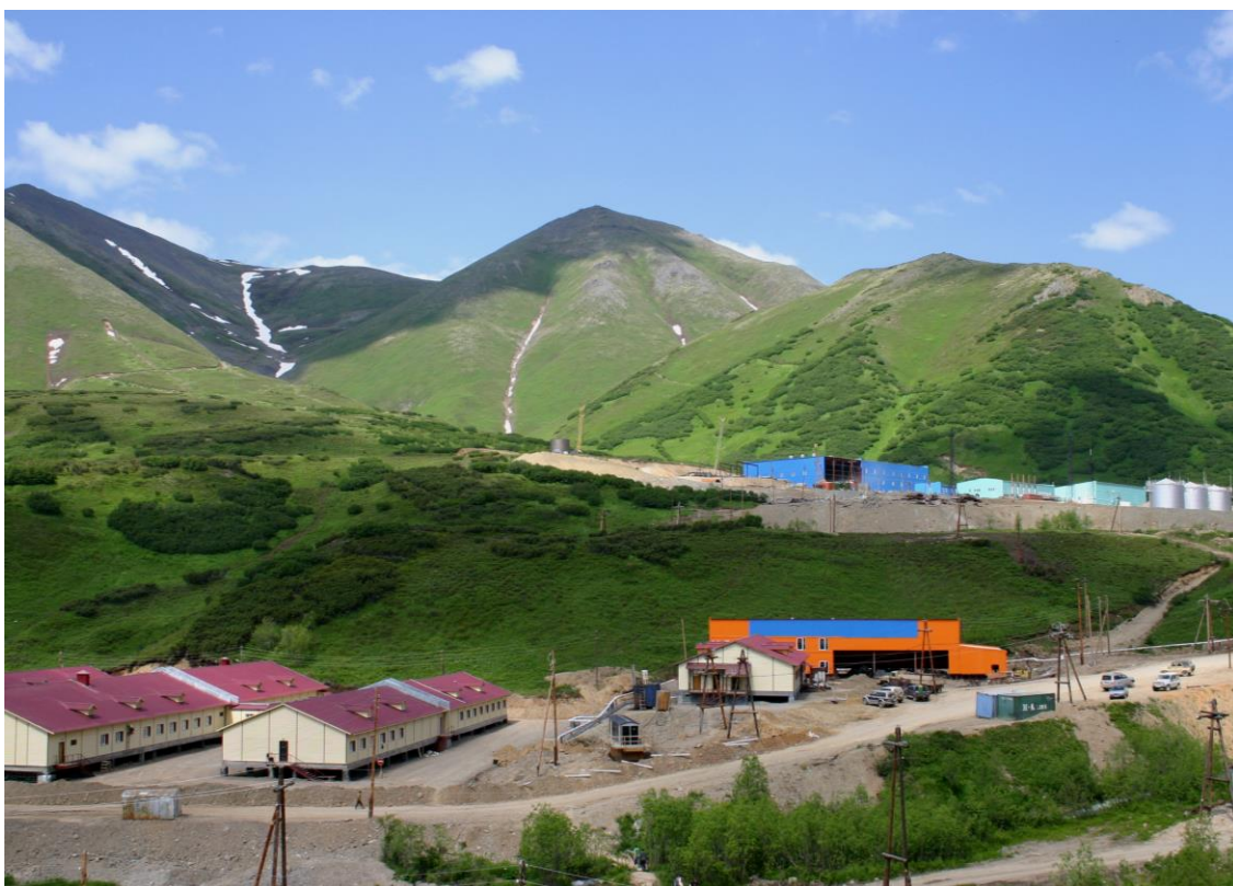
Строительство ГОКа в стадии завершения
