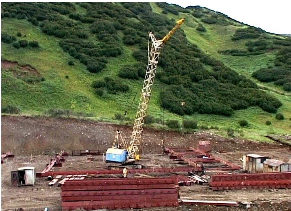
Начало строительства ГОКа
